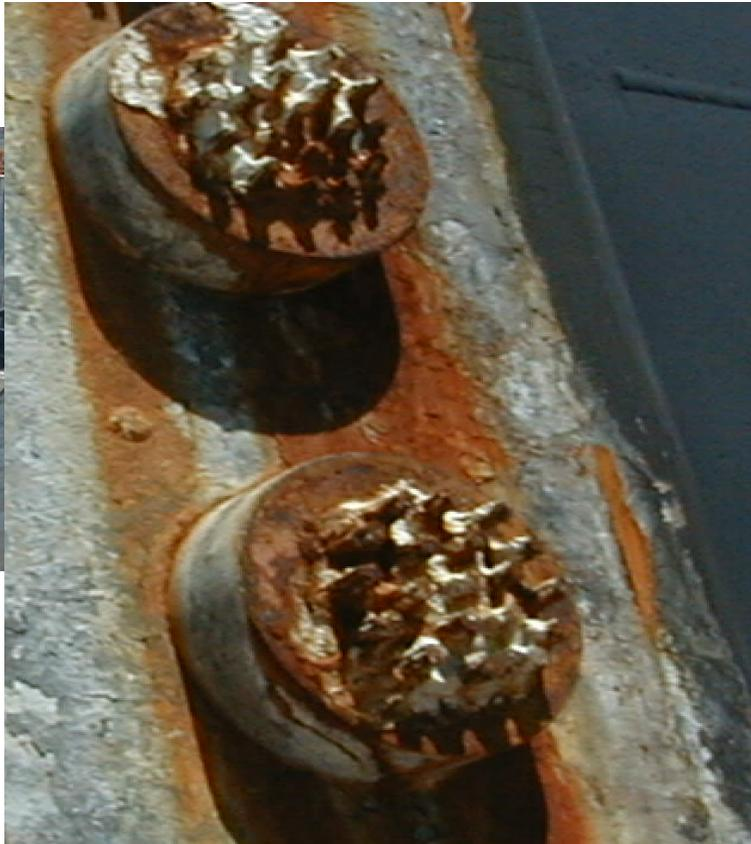
Corrosión detectada en los cabezales en 1989
