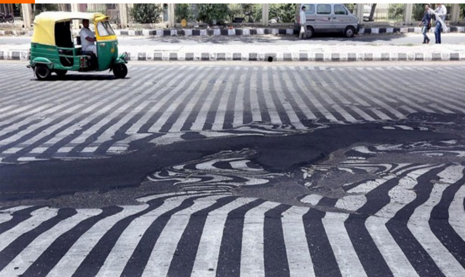
Fuente: Mortífera ola de calor en India derrite hasta el pavimento. Guioteca 2016
